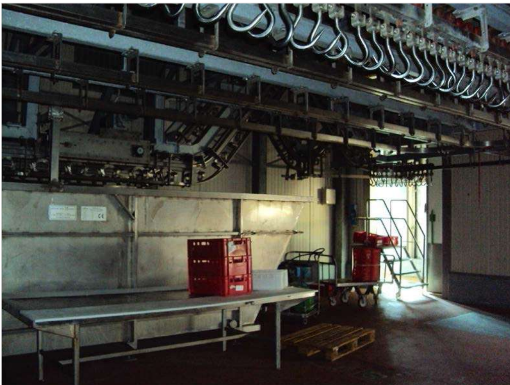
Foto n. 86: Cella conservazione, fabbricato (B1)
