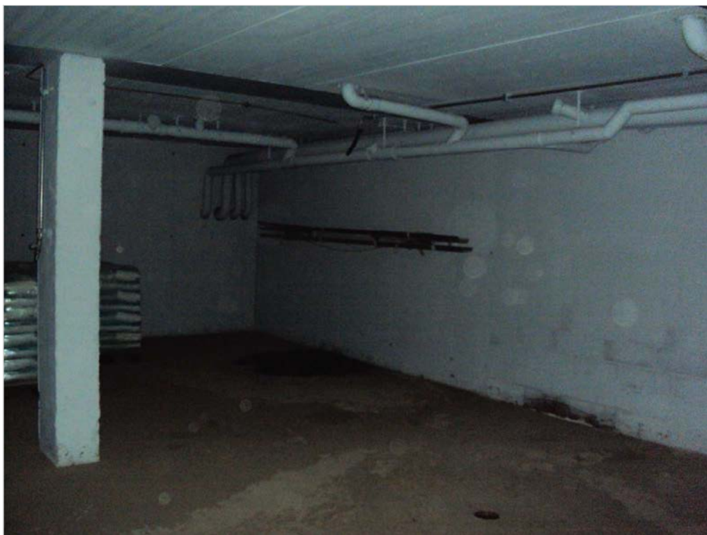
Foto n. 119: Deposito, fabbricato (C2)
