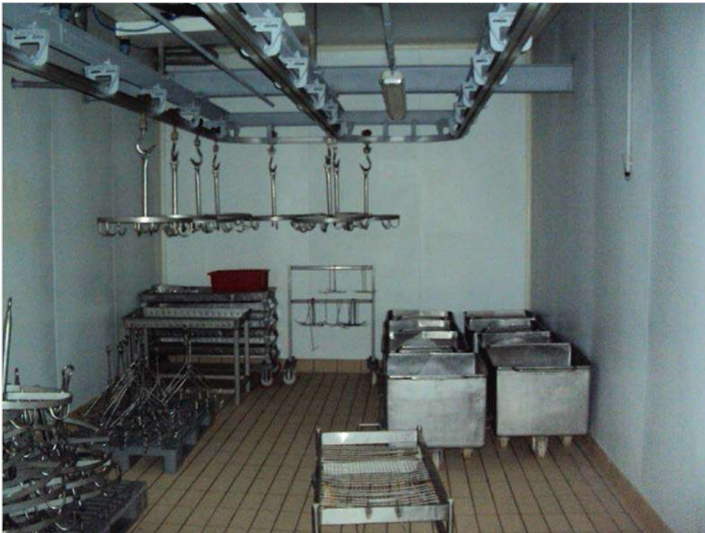
Foto n. 97: Reparto macellazione e lavorazioni, fabbricato (C1)
