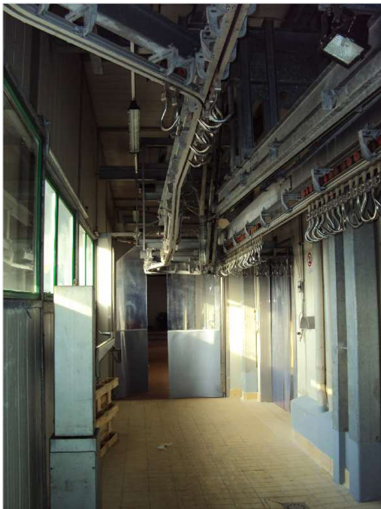
Foto n. 83: Corridoio, fabbricato (B1)
