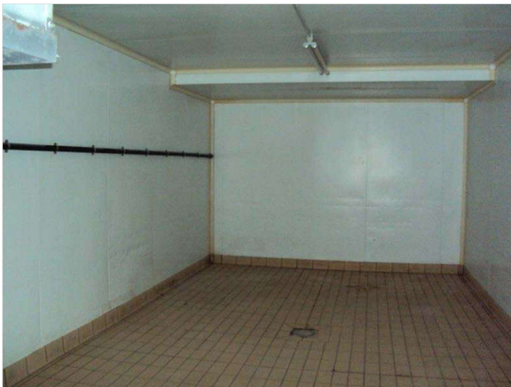
Foto n. 115: Cella frigorifera, fabbricato (C2)
