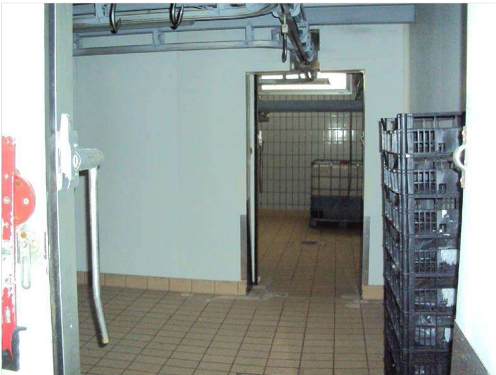
Foto n. 98: Cella frigorifera, fabbricato (C1)
