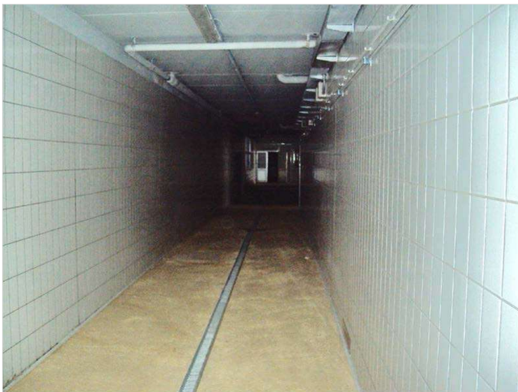
Foto n. 116: Corridoio, fabbricato (C2)
